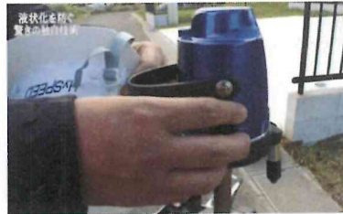
レーザー水平器で砕石パイルを施した 住宅の水平を調査
