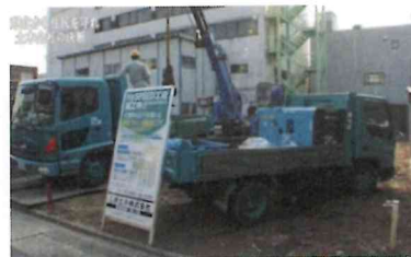
代理店様の現場の様子 オリジナルの施工説明看板も作りが なっています。
