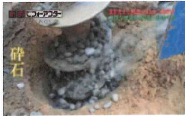
早速砕石を投入、地中に砕石パイルを 施工します。
